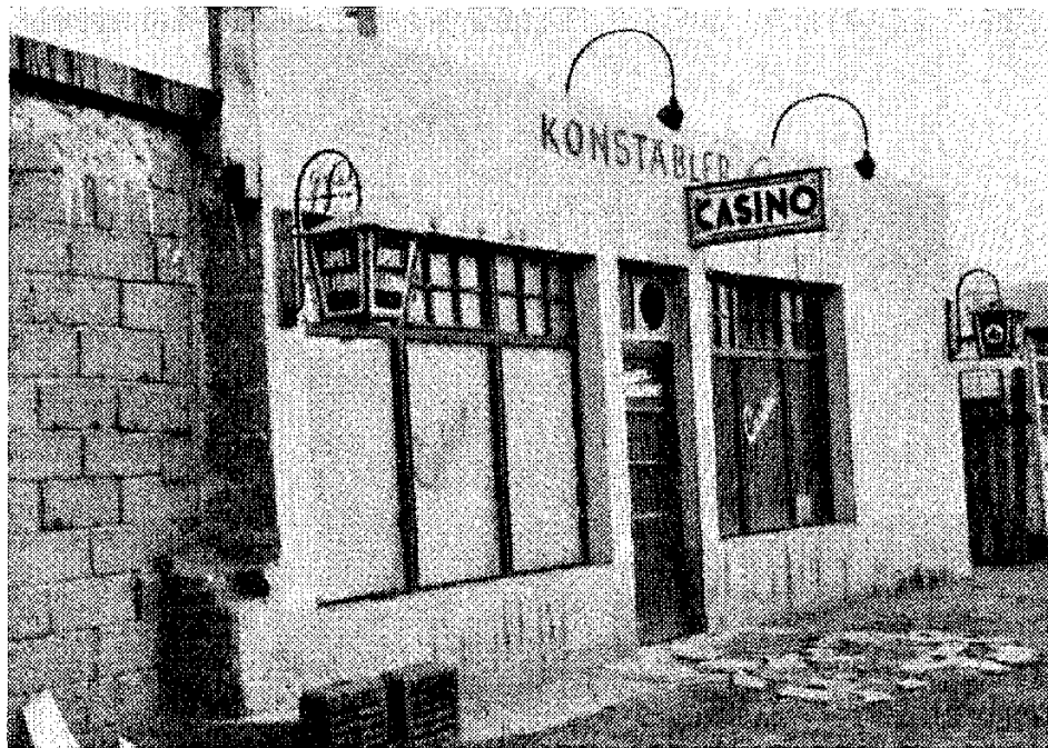
Frankfurt am Main Spielcasino „Kleines Konstabler Casino“, Allerheiligenstraße 78 (Außenansicht mit Leuchtreklame)
